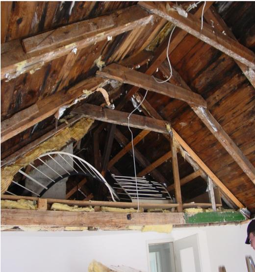
Zu sanierendes, teilgedämmtes Dach,
