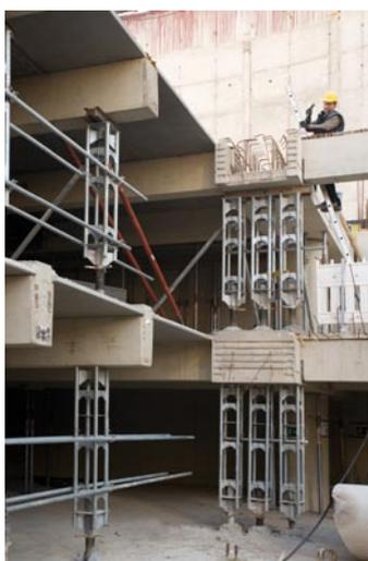
Die bis zu 6,00 m hohen einhäuptigen polygonalen Außenwände werden mit der Manto-Großrahmenschalung geschalt, die von Stützböcken gehalten wird
