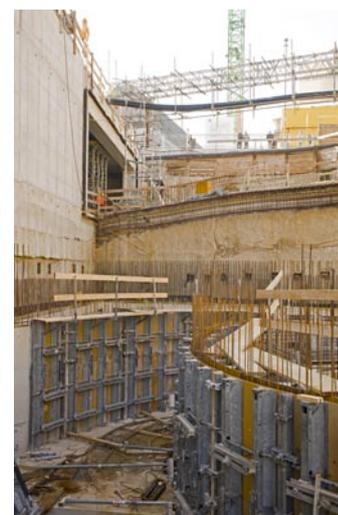
Beim Bau der unterirdischen Parkhausspindel konnte die Ronda-Rundschalung ihre Vorzüge beweisen: Die robusten, einsatzfertige Schalelemente lassen sich mit dem eingebauten Spindelsystem auf jeden gewünschten Radius (ab 2,75 m) millimetergenau einstellen
