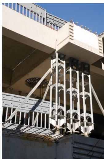
Um den hohen Lastabtrag aus den Fertigteilunterzügen sicher abzuleiten, werden an vielen Stellen Lastrahmenstützen von Harsco Infrastructure eingesetzt
