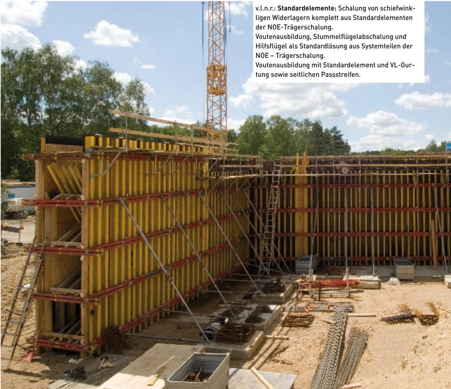
v.l.n.r.: **Standardelemente:** Schalung von schiefwinkligen Widerlagern komplett aus Standardelementen der NOE-Trägerschalung.
