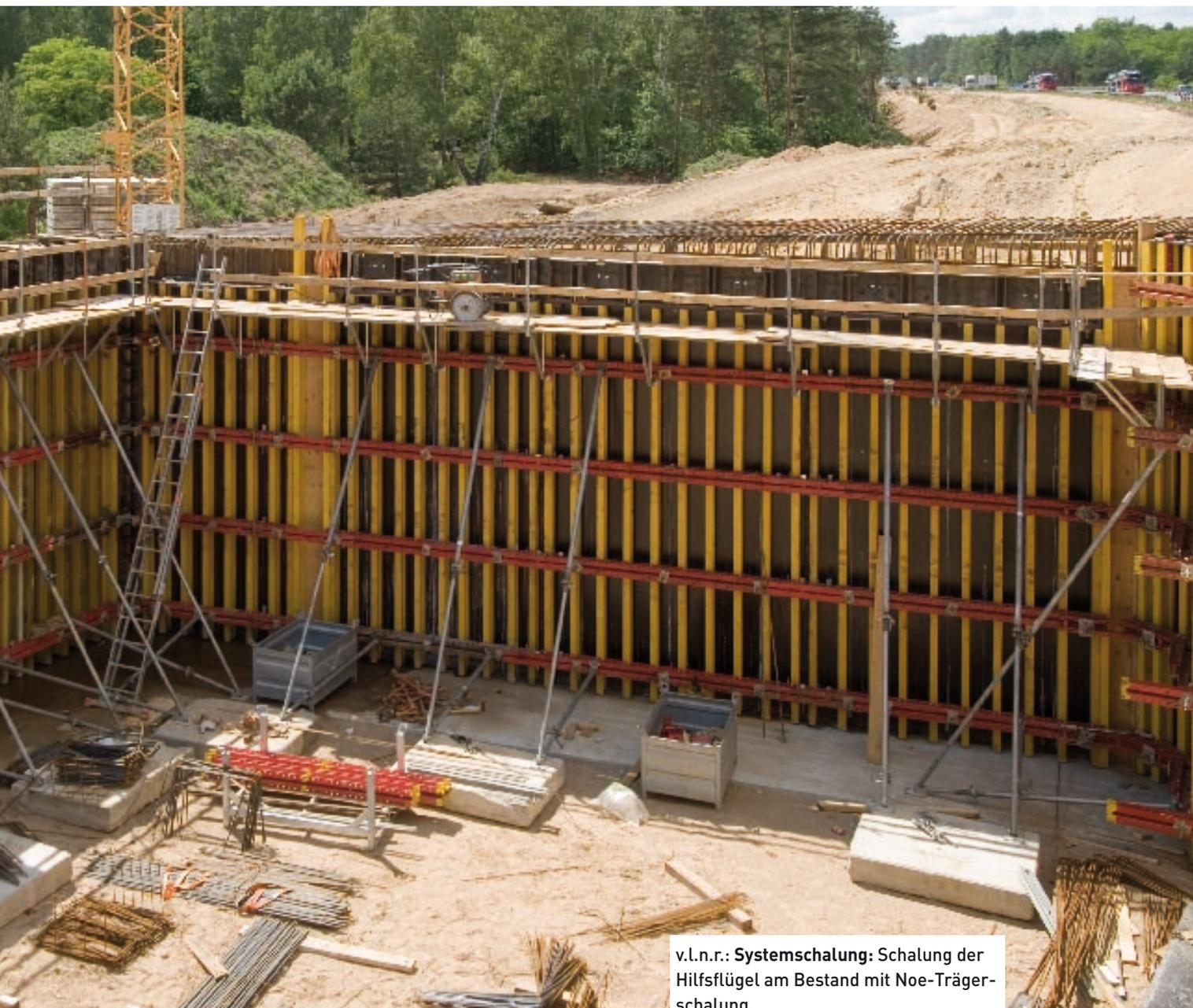
v.l.n.r.: **Systemschalung:** Schalung der Hilfsflügel am Bestand mit Noe-Trägerschalung.
