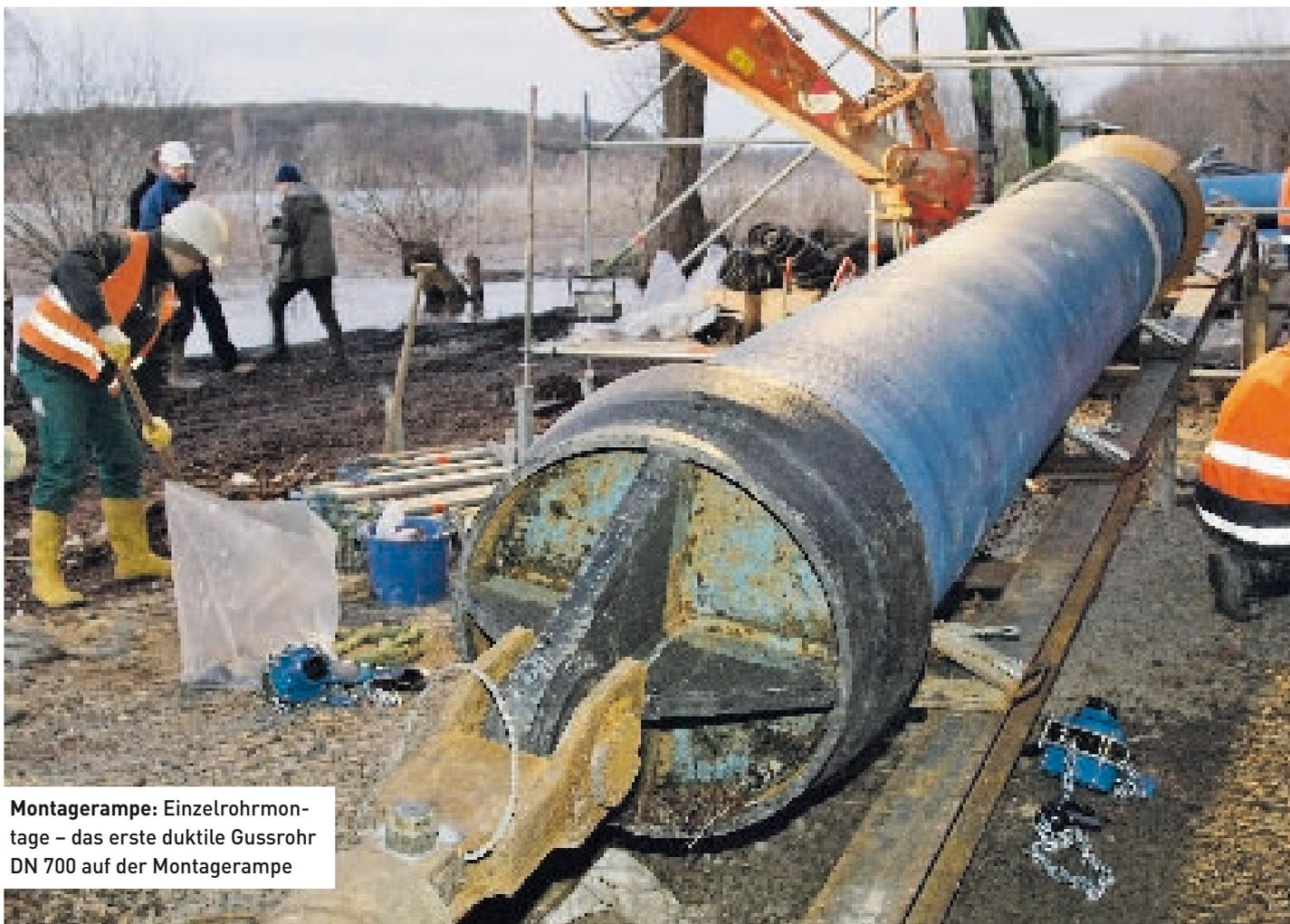
**Montagerampe: Einzelrohrmontage – das erste duktile Gussrohr DN 700 auf der Montagerampe**
