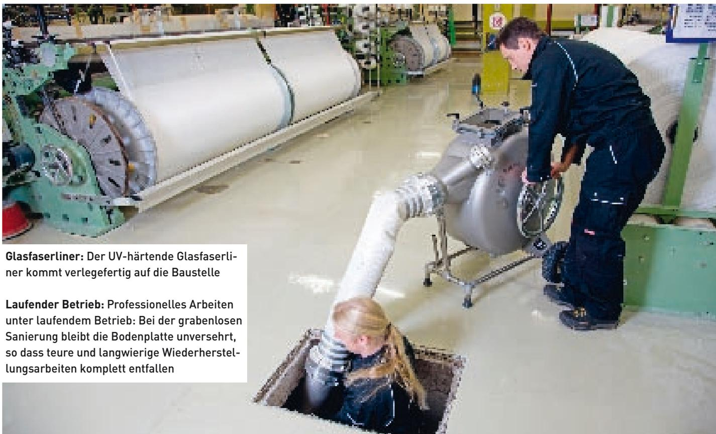
**Glasfaserliner:** Der UV-härtende Glasfaserliner kommt verlegefertig auf die Baustelle
