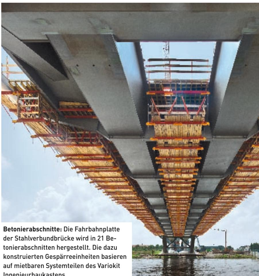
**Betonierabschnitte:** Die Fahrbahnplatte der Stahlverbundbrücke wird in 21 Betonierabschnitten hergestellt. Die dazu konstruierten Gespärreeinheiten basieren auf mietbaren Systemteilen des Variokit Ingenieurbaukastens
