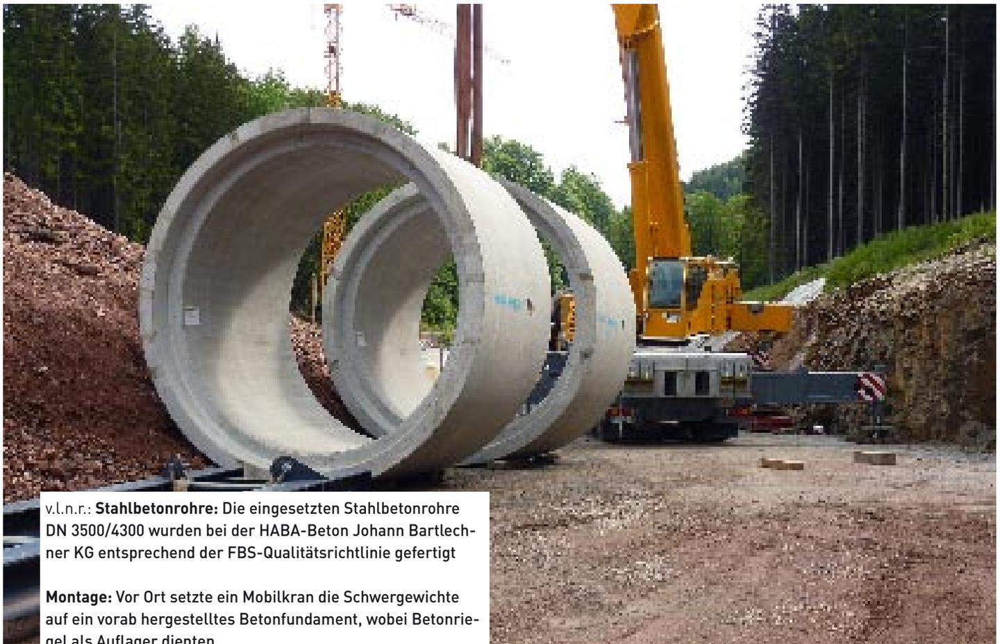
v.l.n.r.: **Stahlbetonrohre:** Die eingesetzten Stahlbetonrohre DN 3500/4300 wurden bei der HABA-Beton Johann Bartlechner KG entsprechend der FBS-Qualitätsrichtlinie gefertigt
