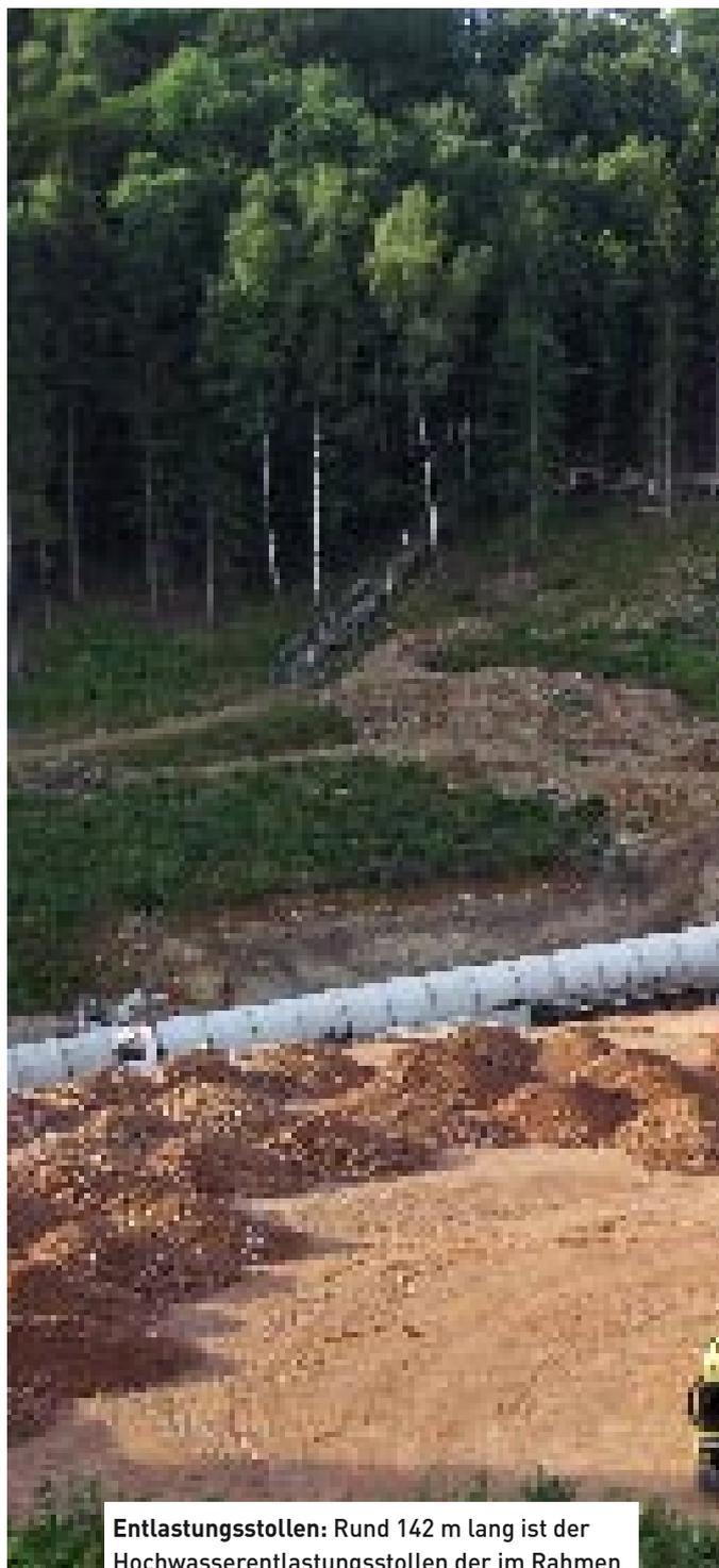
**Entlastungsstollen:** Rund 142 m lang ist der Hochwasserentlastungsstollen der im Rahmen der Erweiterung des Hochwasserrückhaltebeckens (HRB) Glashütte I neu gebaut wird
