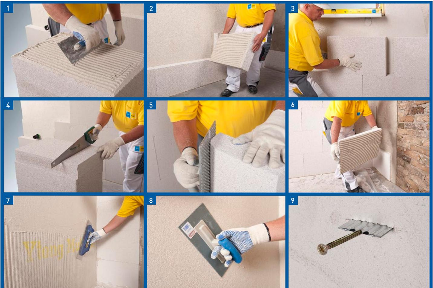
**1** Der speziell auf das Produkt abgestimmte und frisch angerührte Ytong Multipor Leichtmörtel wird vollflächig mit einer Zahntraufel (Zahnung 10-12 mm) auf der Plattenunterseite aufgetragen und anschließend mit den Zähnen der Glattkelle „durchgekämmt“.
