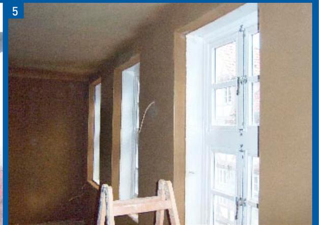
tz ausgetrocknet war, Ytong Multipor Mineralverband auf den ebenen klebt und zusätzlich mit im Fachwerkholz befes-
