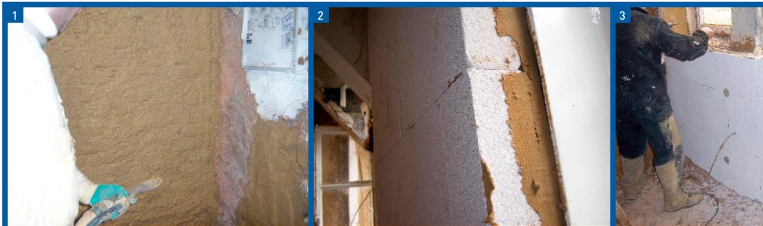
**1** Aufbringen des Ytong Multipor Lehmörtels als Ausgleichputz, der speziell für die energetische Sanierung von historischen Fachwerk-Gebäuden optimal geeignet ist.
