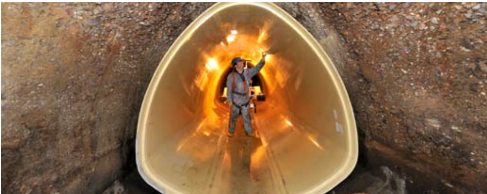
Montiertes GFK-Rohr im Altkanal
