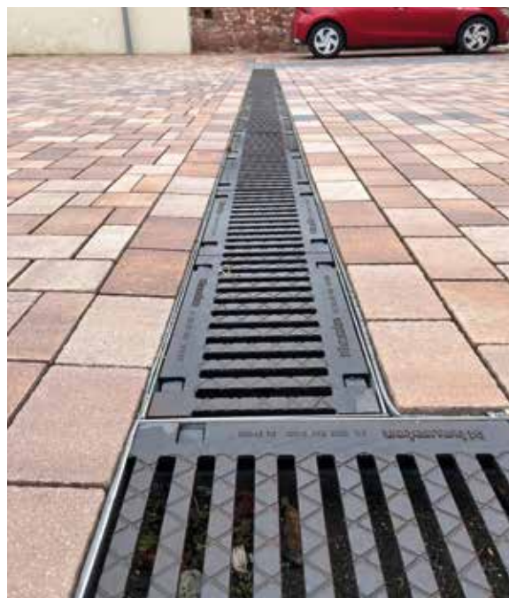
Niederschlagswasser wird von den versiegelten Flächen in der Drainfix Clean Rinne gesammelt, abgeleitet und währenddessen – beim Passieren des Filtersubstrats in der Rinne – zuverlässig von Schadstoffen befreit
