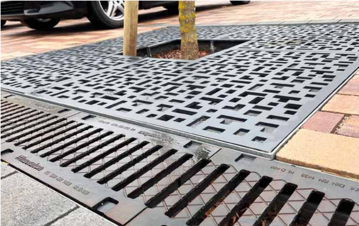
Trotz durchgängiger Befestigung der Oberfläche – unter anderem für Parkplätze und die künftige Ladeinfrastruktur – wurde ein funktionierendes System zur Baumbewässerung realisiert
