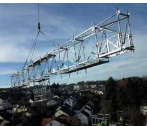
Vormontage am Boden und Einheben per Kran: Überbrückung aus dem Allround Fachwerkträger
