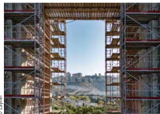
Aluminium-Träger FlexBeam als materialsparendes Deckengerüst
