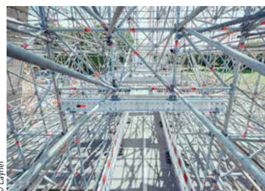
Aluminium-Träger TwixBeam zur Überbrückung einer Durchfahrt bei der Einrüstung eines Pylons
