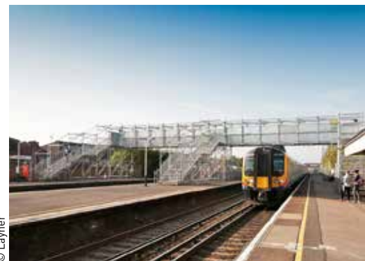
Temporäre Fußgängerersatzbrücke aus Allround Brückenträger – inklusive Allround-Treppenturm sowie Verkleidung mit Layher Protect-System
