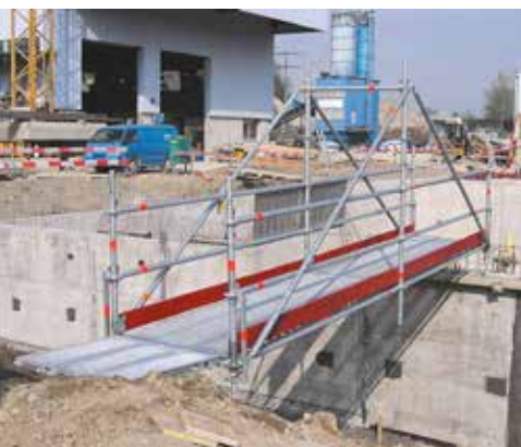
Baustellenüberbrückung aus dem Layher AllroundGerüst
