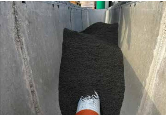
Carbotec 100 Filtersubstrat wird in die Rinnen eingebracht. Das Drainagerohr in der Rinnensohle dient der Wasserableitung
