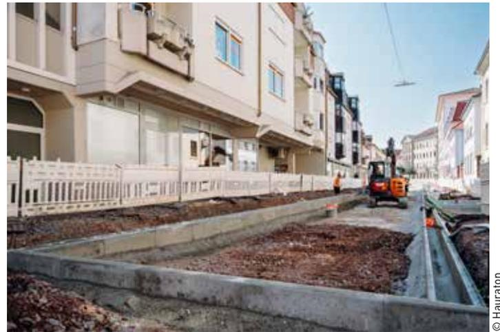
Die stabilen Rinnen sind nach der Fertigstellung des Oberflächenbelags hoch belastbar, z.B. für Lkw
