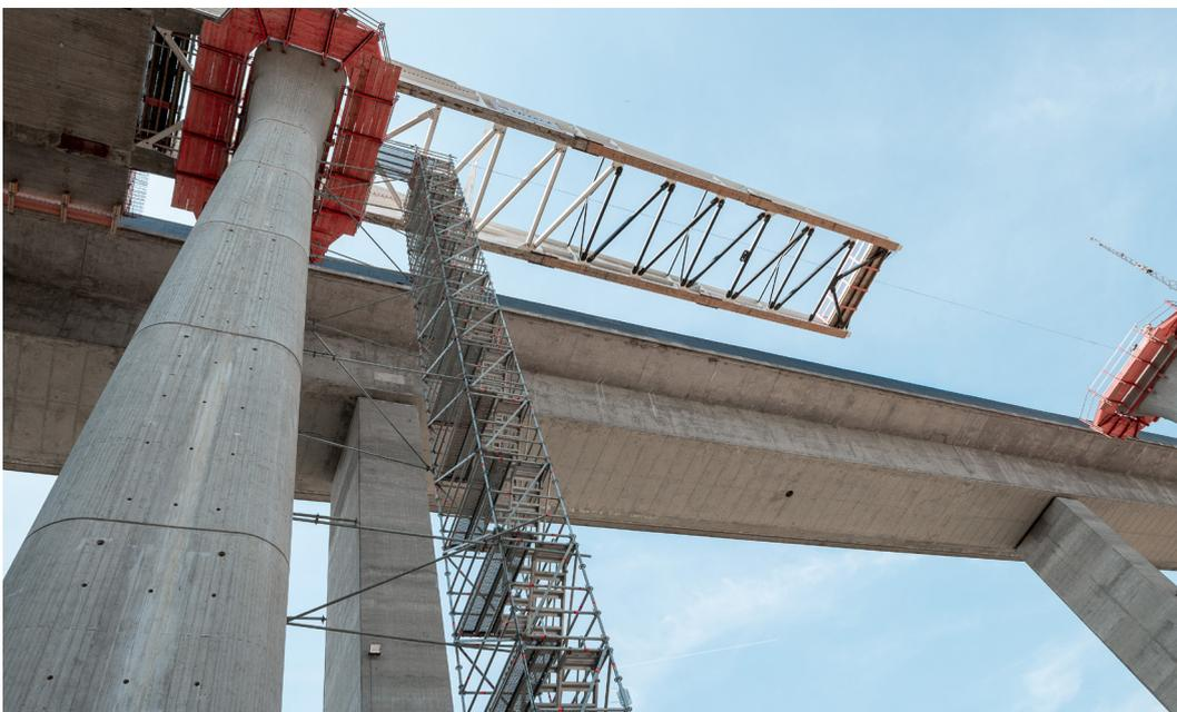
Beim Neubau der Talbrücke Krondorf mittels Taktschiebeverfahren werden parallel zum Bau der Brückenpfeiler acht Bautreppentürme mit bis zu 36 Meter Höhe errichtet. Durch Einsatz des Allround Modultreppenturms lassen sich diese einfach modulweise am Boden vormontieren und per Kran zusammensetzen. Dank Typenprüfung bis zur maximalen Aufbauhöhe von 115 Metern entfällt zudem ein statischer Nachweis im Einzelfall.
