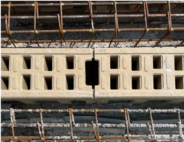
Für die **Abdichtung des Sicherheitsfalzes** ist eine spezielle Spritzdüse nötig, die ACO auf Anfrage zur Verfügung stellt. Die Abdichtung des Sicherheitsfalzes wird von WHG-zugelassenen Betrieben durchgeführt, die das notwendige Wissen und die Ausrüstung zur Abdichtung von großen Fugen mitbringen.
