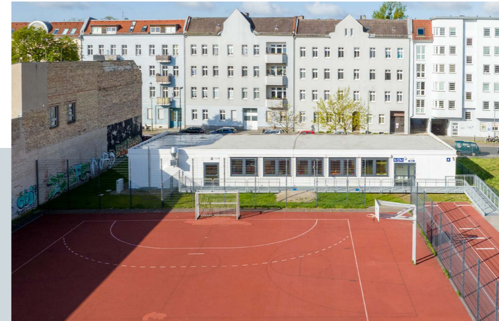
Edison-Grundschule Im Rahmen der Gesamtsanierung und Erweiterung wurde auf dem Schulgrundstück ein Interimsstandort geschaffen. Dazu gehört auch eine eingeschossige Mensa mit 365 m 2 Bruttogrundfläche. Sie besteht aus 20 Containern der Baureihe ProENERGY und wird voraussichtlich bis 2026 in Betrieb sein.
