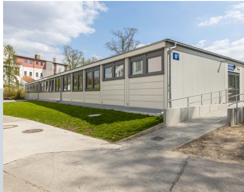
Schmökewitzer Insel-Schule Während der energetischen Sanierung des Gesamtstandortes und der barrierefreien Erschließung der Schmökewitzer Insel-Schule dient eine ProENERGY-Anlage als Interimsgebäude. Sie besteht aus 35 Containern und bietet auf 621 m 2 Platz für vier Klassenräume und einen Sanitärbereich.
