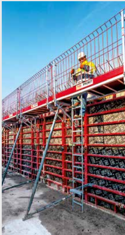
Die Arbeitsbühnen werden am Element der entsprechenden Breite montiert und verbleiben auch bei der Zwischenlagerung an der Schalung.
