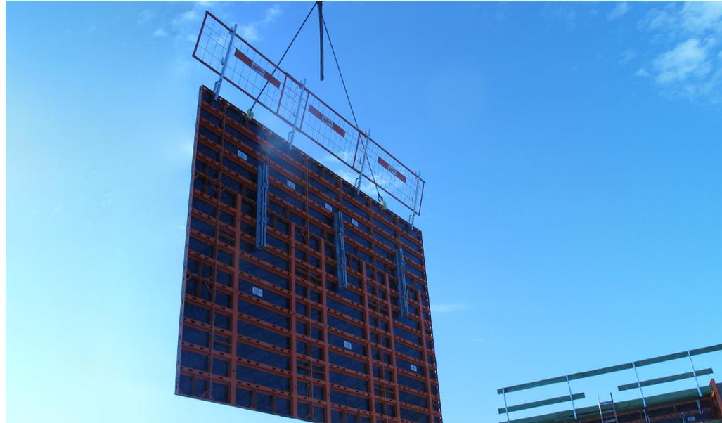
Die Krananhängung KA dient als Lastaufnahmemittel beim Versetzen von einzelnen Elementen bzw. vormontierter Elementeinheiten der Leichtschalung NeoR. Durch die Leichtigkeit der NeoR-Schalung lassen sich große Elementeinheiten bis ca. 25qm transportieren, was sehr viel Zeit spart.
