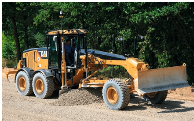
6 Cat Grader 140M mit ATS-Maschinensteuerung beim Einbau von 32er Frostschutzkörnung mit 8 km/h bei MAX BÖGL in Sengenthal. 140M: Leistung: 201 PS, Hubraum: 7,2 Liter, Drehmoment 1.079 Nm, Scharlänge 3,7 m
