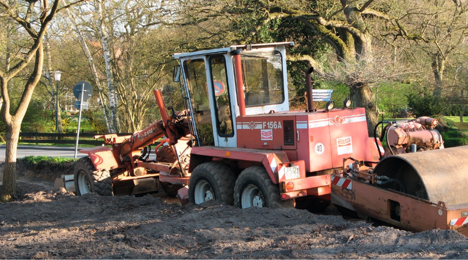
18 Zur effizienten Verdichtung planierter und nivellierter Flächen können Grader am Heck Dreiplattenverdichter tragen oder wie hier eine Anhäng-Vibrationswalze ziehen. Foto: Verfasser
