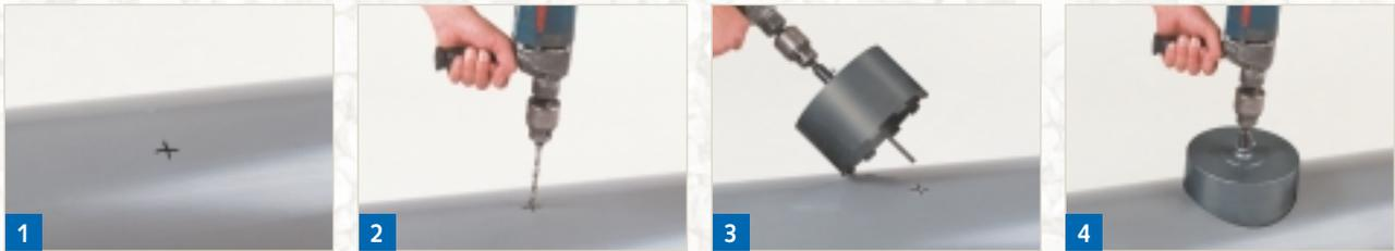
Einbaustelle auf dem Kunststoffrohr – hier CONNEX-Kanalrohr – mit geeignetem Stift markieren (1). Schnittstelle mit Spiralbohrer 8 mm vorbohren (2). Führungsstift der Bohrkronen in diese Bohrung einführen (3). Kernbohrung zentrisch im 90°-Winkel zur Rohrachse erstellen. Durchmesser der Bohrung 162 bzw. 200 mm  $\pm$  1 mm (4). **Unbedingt auf absplitterungsfreie Ausführung achten.**
