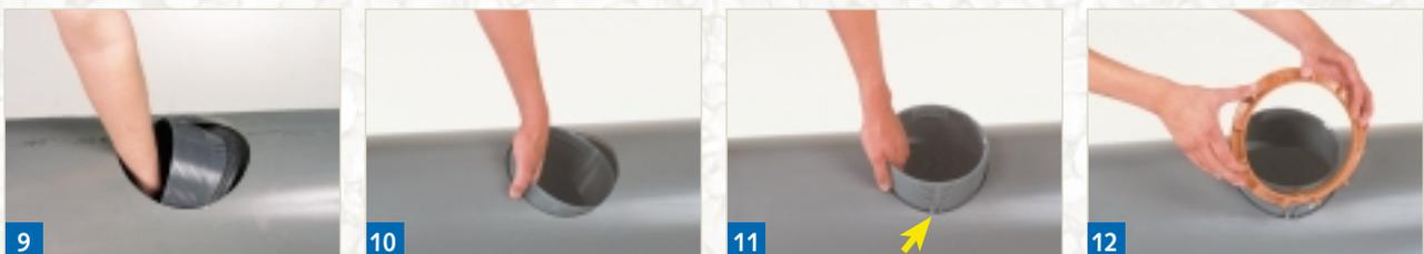
CONNEX-Anschluss im Rohr drehen und dem Rohrradius entsprechend hochziehen (10) bis Halteclips (siehe Pfeil) (11) ausklappen, um den Anschluss zu fixieren. Rotbraunen Distanzring auf Führungsnut des Unterteils aufsetzen (12).
